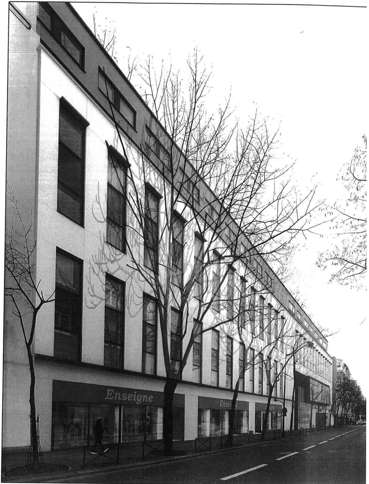
Vue de la façade Ouest Avenue Gambetta vers le Sud
